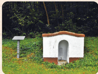
A felújított forránház
